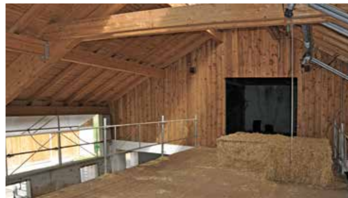
DIE STROHBÜHNE wird über den Futtertisch mit dem Frontlader beschickt. Der Holzbau ist ein Zimmererhandwerk.
