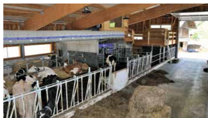
FÜR EIN STRESSFREIES STALLKLIMA sorgt eine Schlauchbelüftung oberhalb des Laufganges. Jede Düse kann individuell eingestellt werden.
