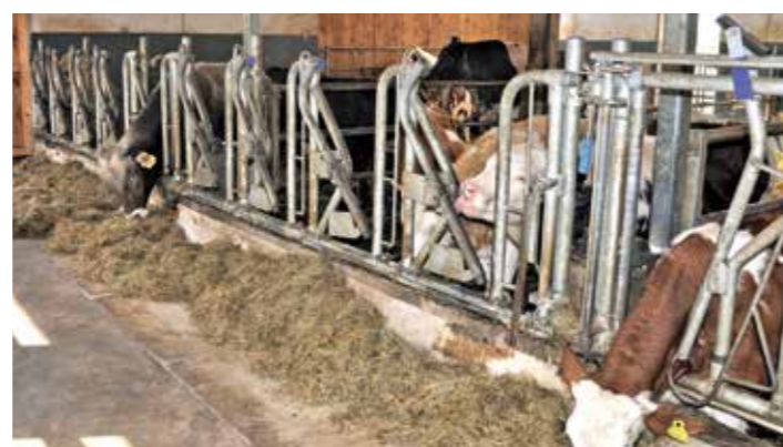
FIRMA FELDER baute zwei verschiedene Aufstallungssysteme je nach Alter der Tiere ein (Maststiere derzeit noch behornt).
