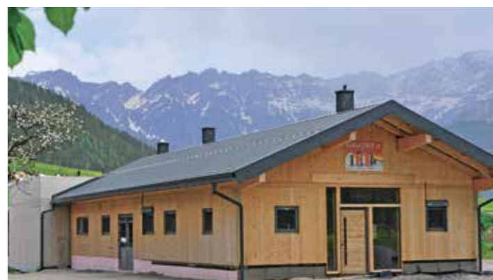
HIGHTECH UND DIGITALISIERUNG: Fertig gespeicherte Abläufe können über das Handy angesteuert werden. Energieeffizienz spielt eine große Rolle.
