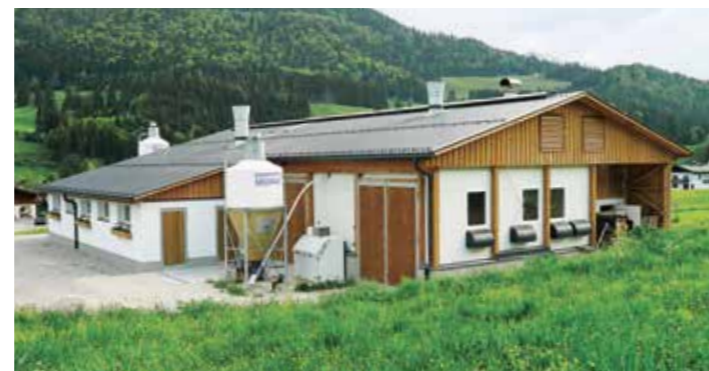
DER GELUNGENE GEBÄUDEKOMPLEX vereint alle Arbeitsabläufe und erlaubt ein kompaktes Arbeiten. In der linken Erweiterung finden die Fleischverarbeitung und die Vermarktung Platz. Rechts befindet sich der Stallbereich.
