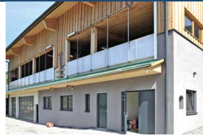
DURCH DIE ENORME HANGLAGE konnten die Garagen und Verarbeitungsräumlichkeiten unterhalb vom Stall eingebaut werden. Die sichere Abdichtung vom darüberliegenden Laufgang war ein zusätzlicher Aufwand und erfolgte mit einem Bitumenguss.
