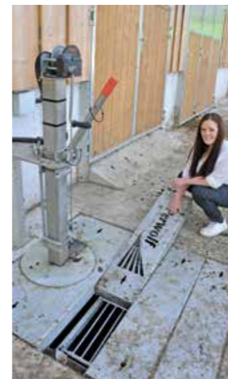
GEFAHRENQUELLEN AUSSCHALTEN – das Sicherheitsgitter bei der Grubenöffnung
