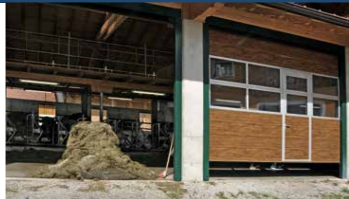
AUF DAS ÄUSSERE ERSCHEINUNGSBILD DER GEBÄUDE legt die Familie großen Wert. Die Rolltore sind für Komfort und Optik ausgewählt worden.
