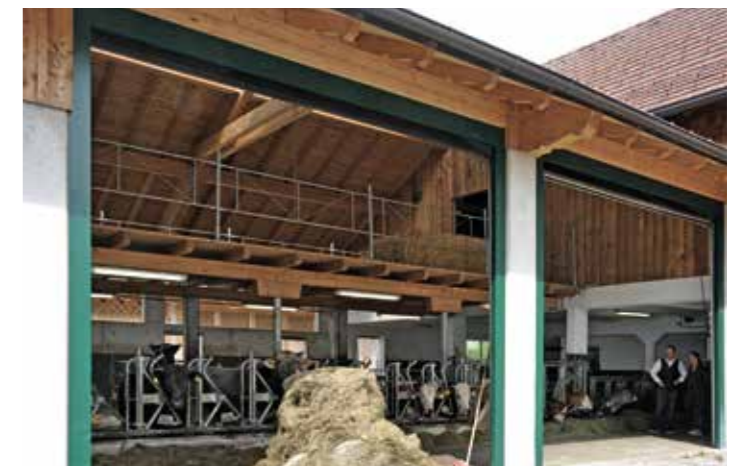
DIE HEUBALLEN WERDEN in der Remise gelagert. Es kann Futter für einige Wochen am befahrbaren Futtertisch vorgelagert werden.
