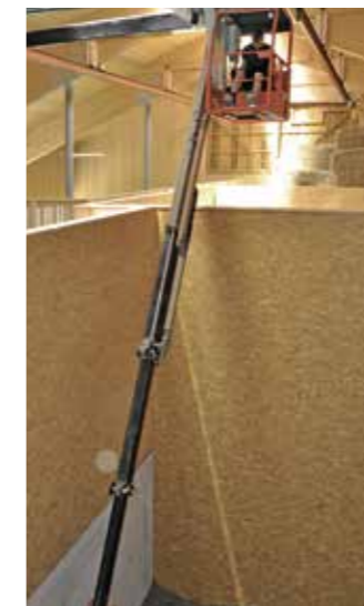
DIE BELÜFTUNGSBOXEN sind so dimensioniert, dass nach der Trocknung das Heu dort verbleiben kann.
